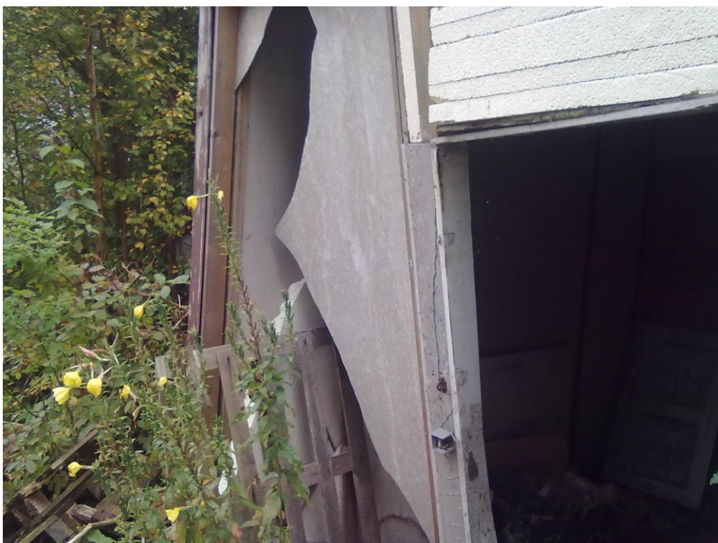
Foto 3: asbestverdacht materiaal aan de wand van een schuur
