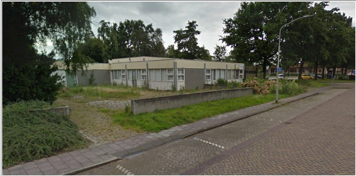
Figuur 7: Klazienaveen, De Jongestraat 37: sociaal cultureel centrum De Snikke voor de sloop in 2016. Bron: Google Streetview.
