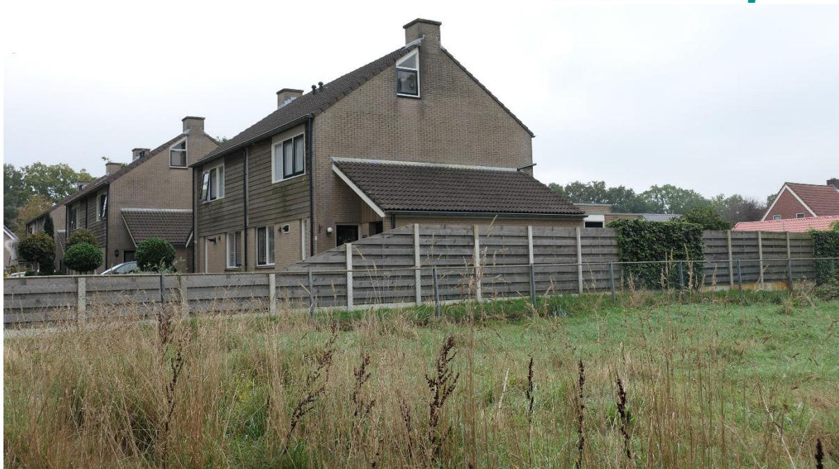
Figuur 4.5 Woningen in de omgeving zijn potentieel geschikt als verblijfplaats voor vleermuizen. Toegang tot het gebouw kan mogelijk verkregen worden via kantpannen, loodslabben, nokpannen en open stootvoegen.
