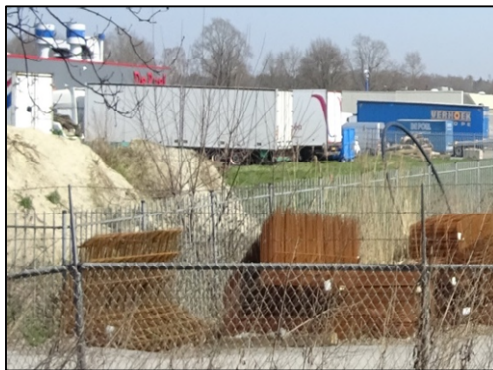
Figuur 4.6. Open ontgraving zuidelijk deel tracé.
