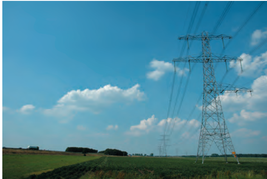
Afb. 5 Nieuwe infrastructuur in beekdal Sleenerstroom
