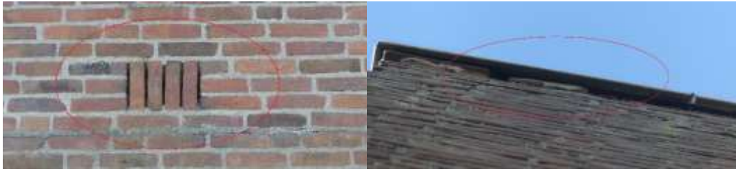
Foto 1 Impressie van geschikte invliegopeningen. Links de open stootvoegen, rechts de ruimte onder de loodstrip- pen.
