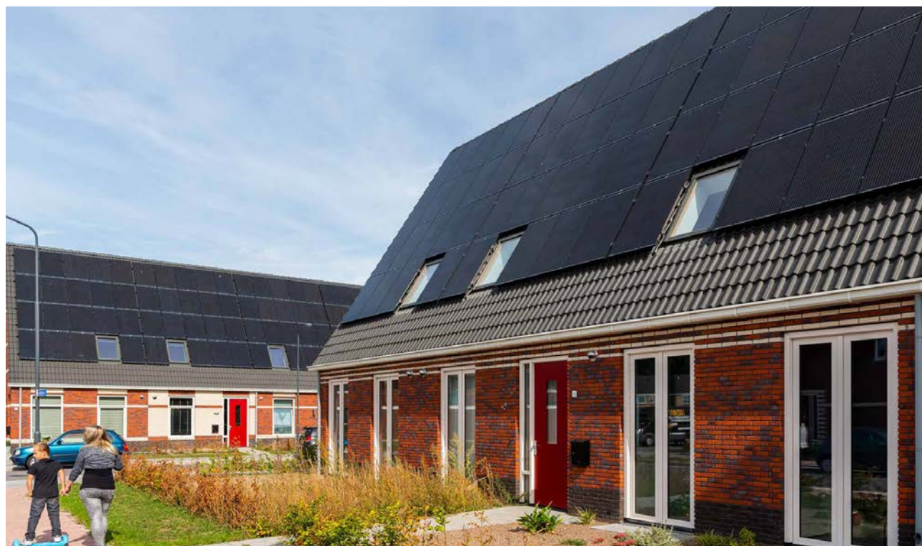
Zonnepanelen in een regelmatig patroon in overeenstemming met de dakvorm
