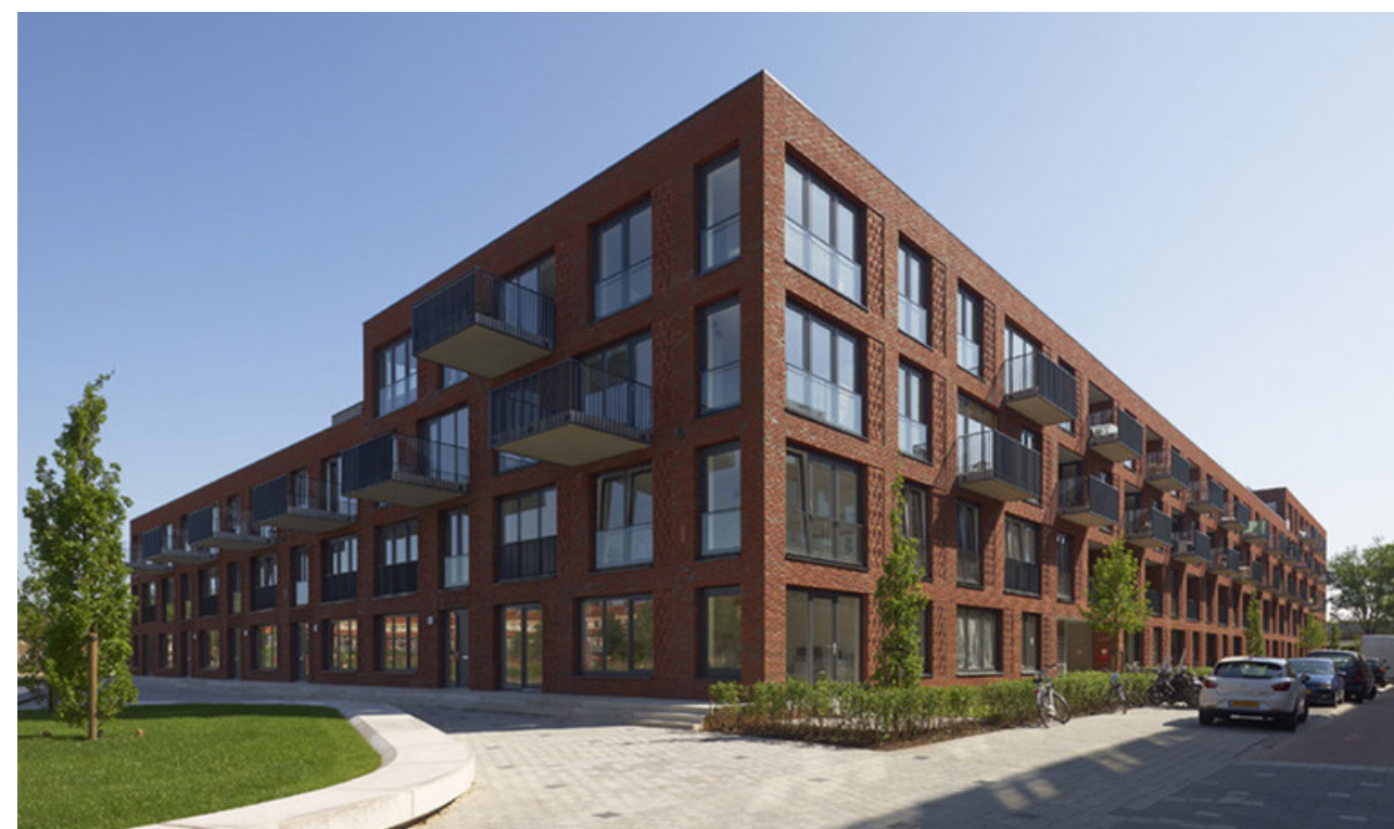
De balkons zijn ondergeschikt aan het totale volume
