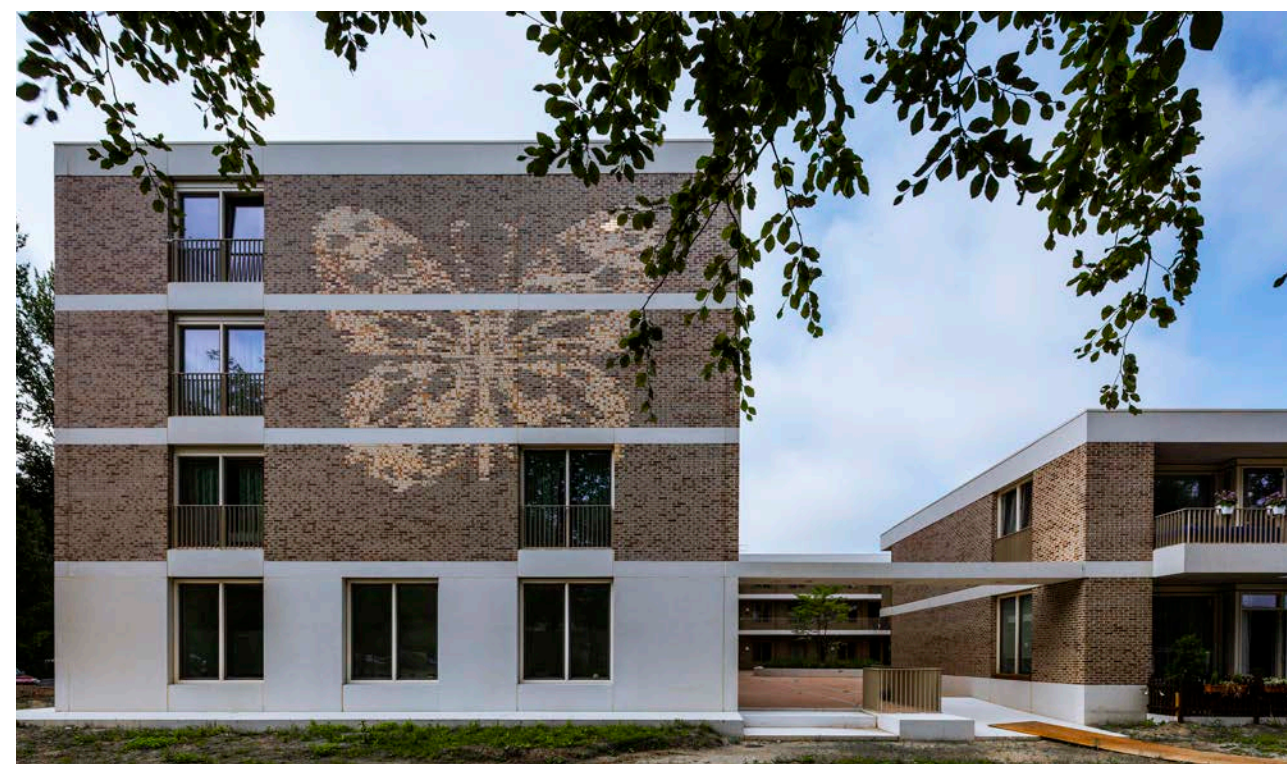
Zijgevels zijn voorzien van openingen
