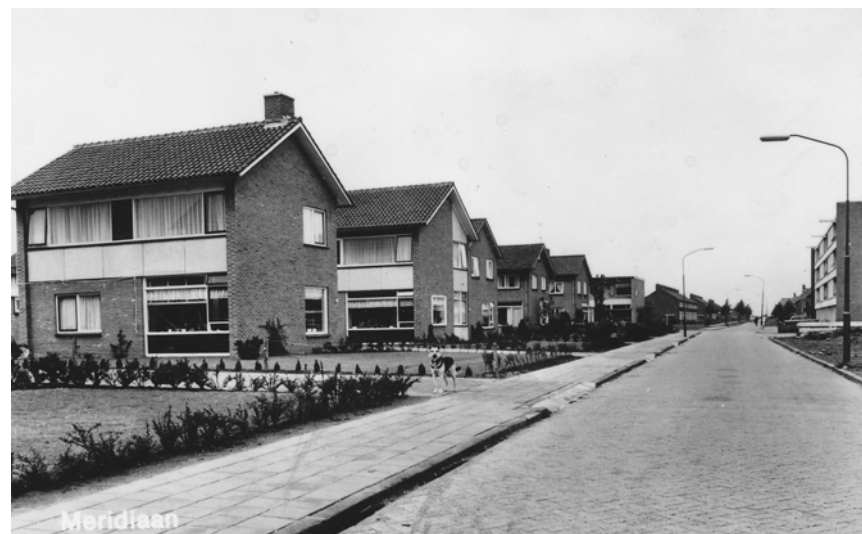
De Meridiaan, gezien vanuit het zuiden, met links de vrijstaande woningen tegenover de zuidelijke portiekflat.
