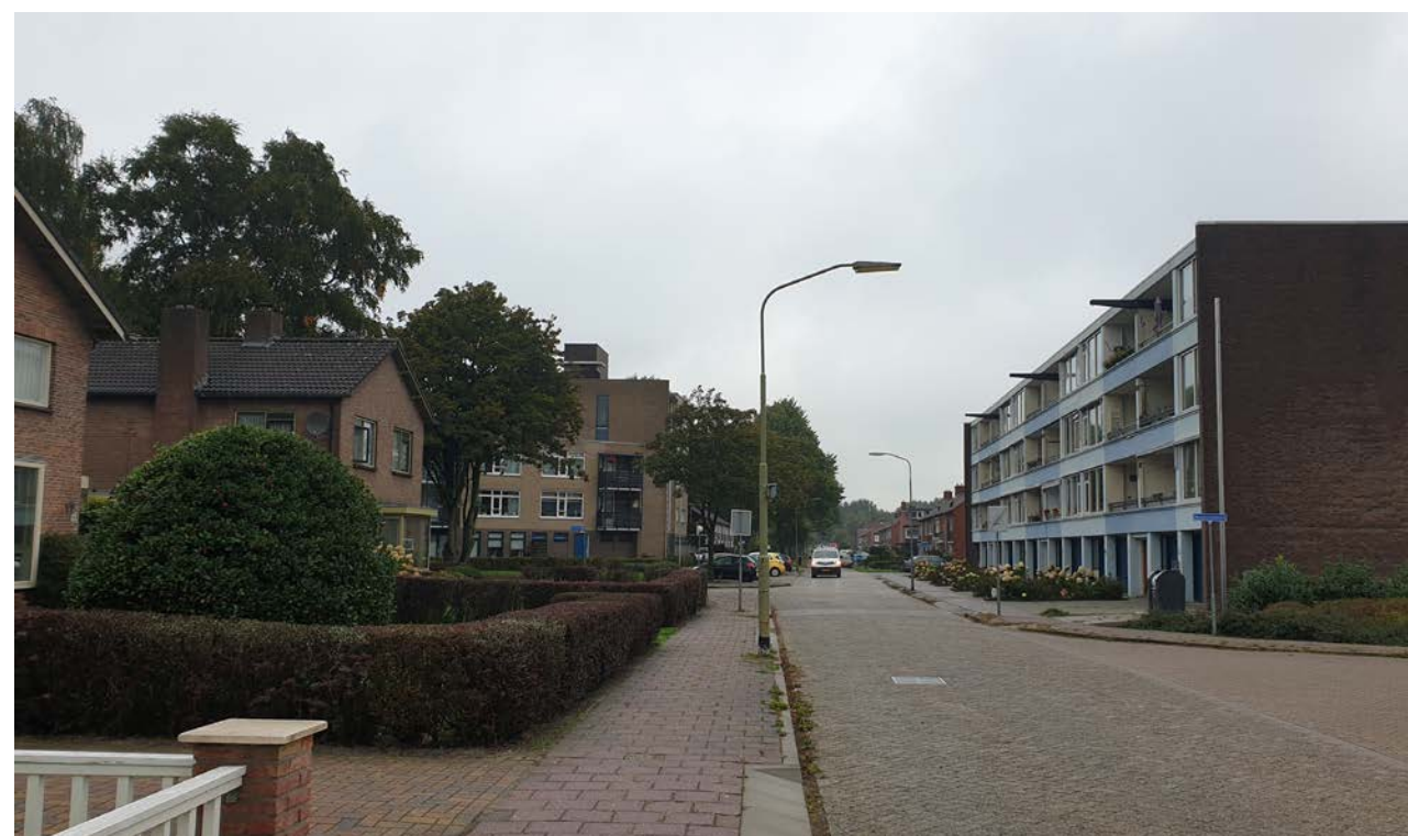
Bestaande situatie: de Meridiaan gezien richting het noorden. Links in beeld de vrijstaande woningen en de Zuiderkroon, rechts één van de flats.
