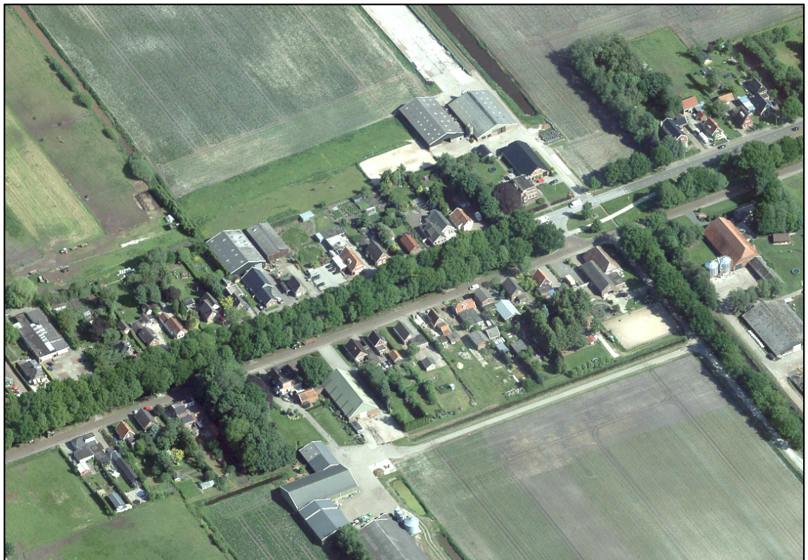
Lintbebouwing kanaaldorp van de Veenkoloniën (enkellint): Weedingerkanaal – Nieuw-Weerdinge
