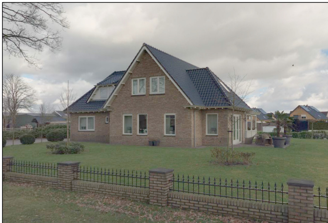
In het kader van “Bouwen in de Linten” gerealiseerde woning aan de Sint Gerardusstraat te Barger-Oosterveld
