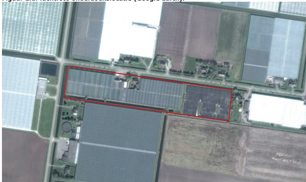
Figuur 2.1: luchtfoto onderzoekslocatie (Google Earth).
