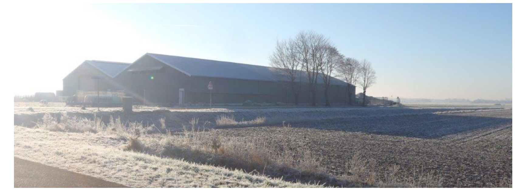
Zicht op huidige locatie vanaf Bladderswijk
