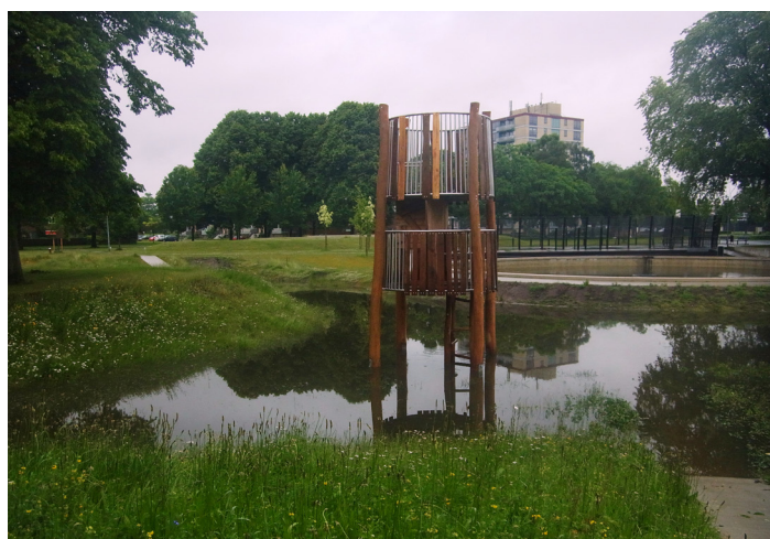
Een deel van de oplossing is al gerealiseerd: een verlaagd Haagjespark waardoor bij extreme neerslag het overtollige water in de berging stroomt in plaats van op straat en in de huizen. Aanvullend wordt in 2015-2016 nog een afvoer naar het Oranjekanaal gerealiseerd.
