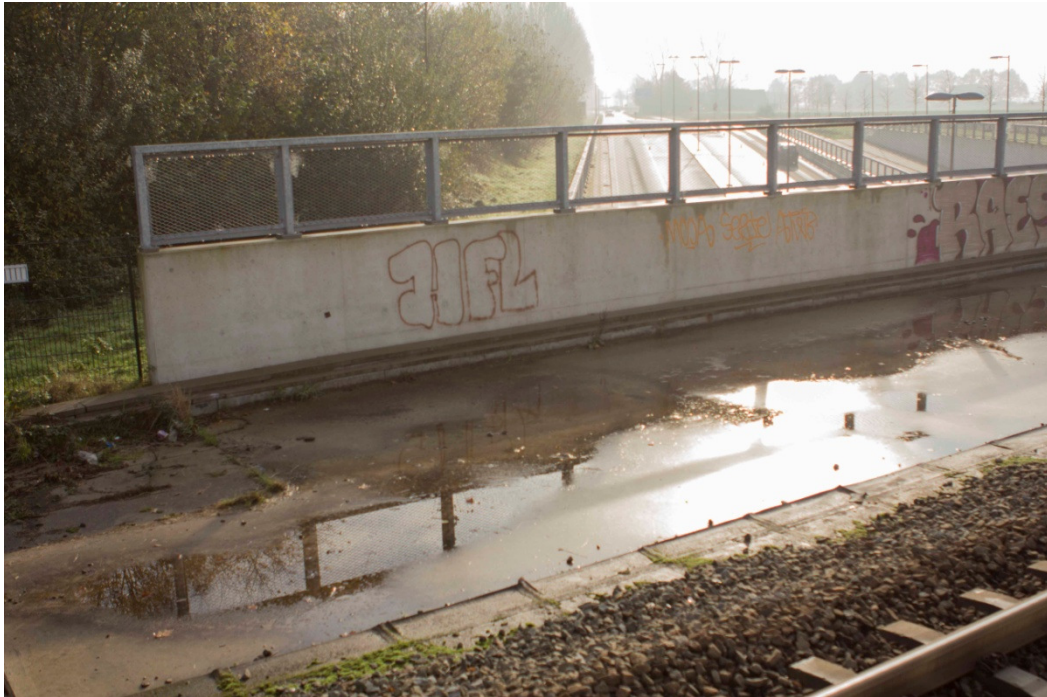
Figuur 11. betonnen plaat van het viaduct over de Nieuw-Amsterdamsestraat
