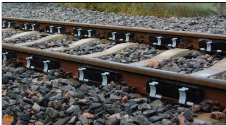
Figuur I-3 Een voorbeeld van de bronmaatregel raildempers. Dit zijn de zwarte rubberen blokken die in dit geval tegen de rails worden geklemd.
