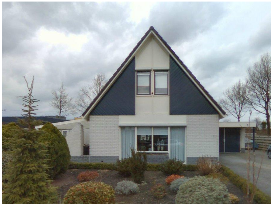
Figuur I-22 Foto gevel Tortelduif 37
