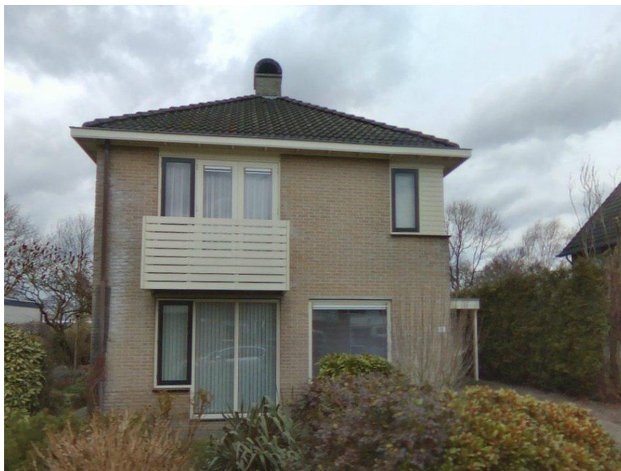
Figuur I-46 Foto gevel Tortelduif 41
