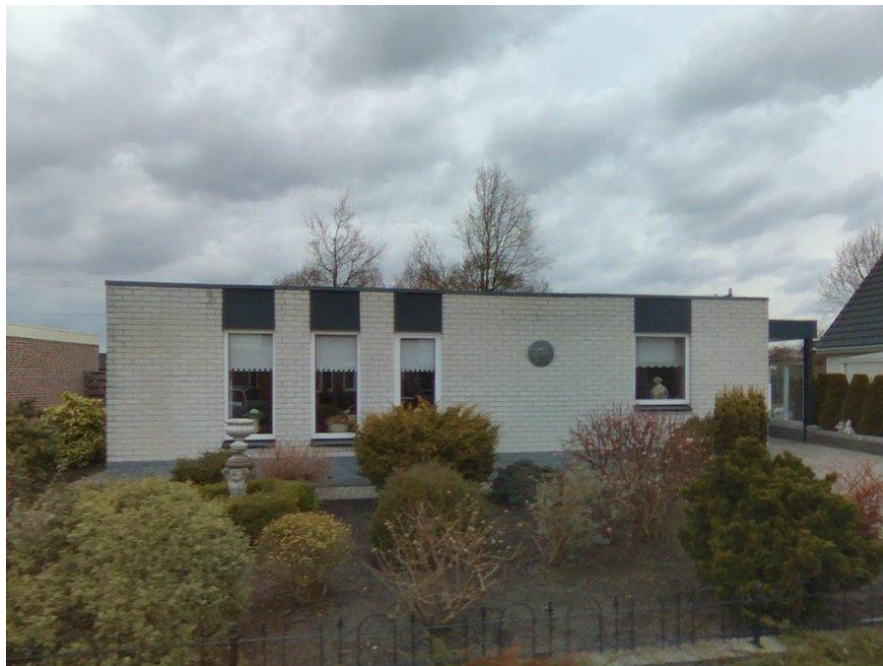
Figuur I-28 Foto gevel Tortelduif 38
