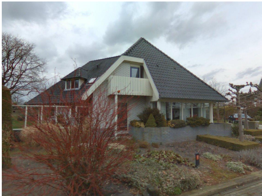
Figuur I-10 Foto gevel Sierduif 13
