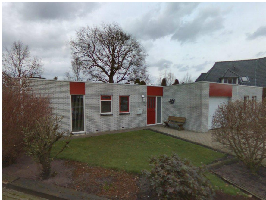
Figuur I-16 Foto gevel Sierduif 15
