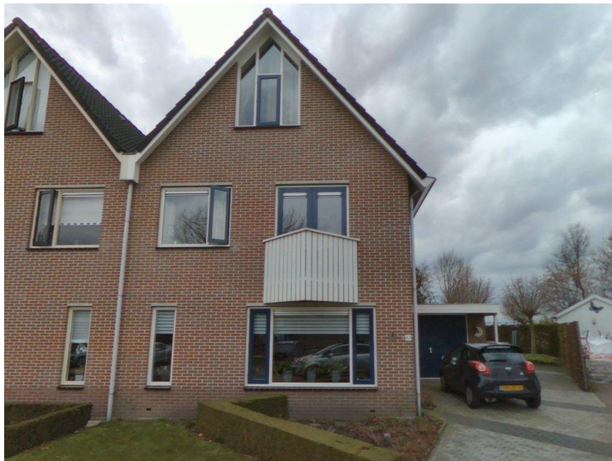
Figuur I-70 Foto gevel Tortelduif 44
