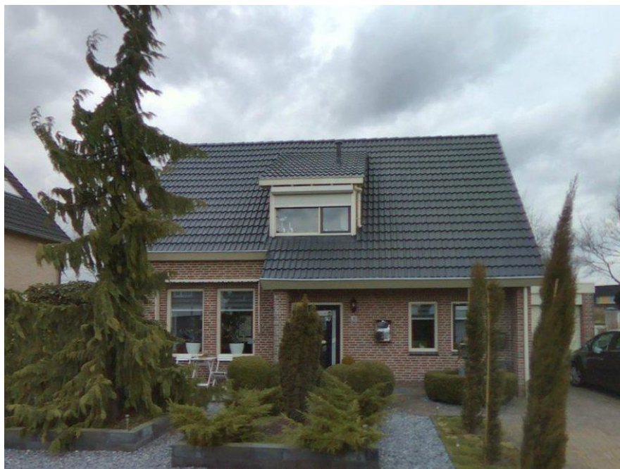
Figuur I-34 Foto gevel Tortelduif 39
