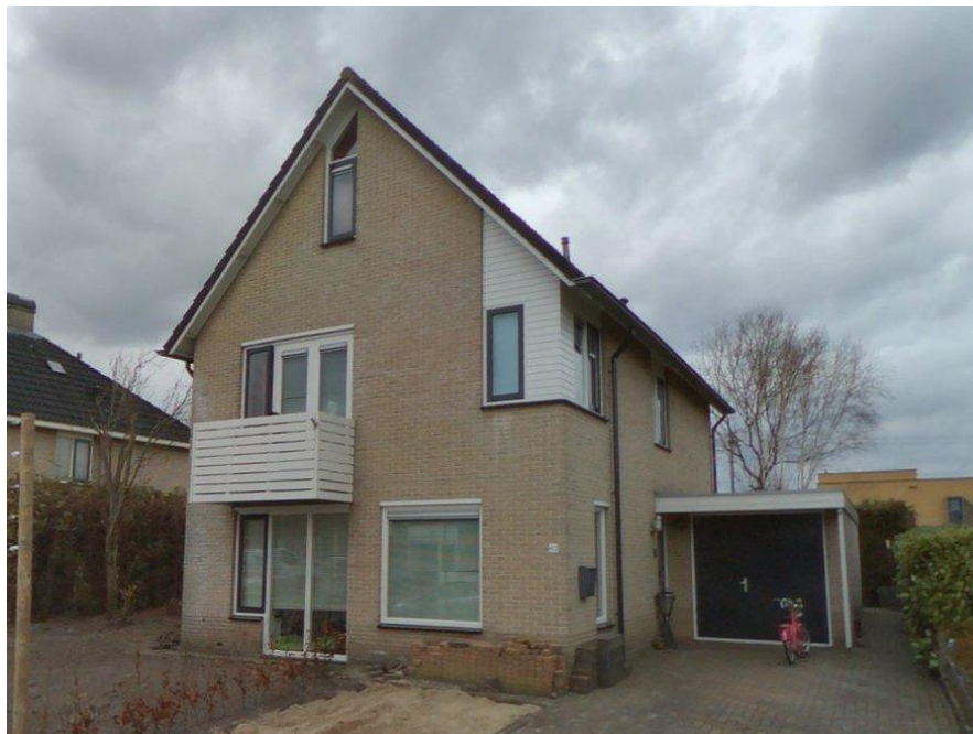
Figuur I-40 Foto gevel Tortelduif 40
