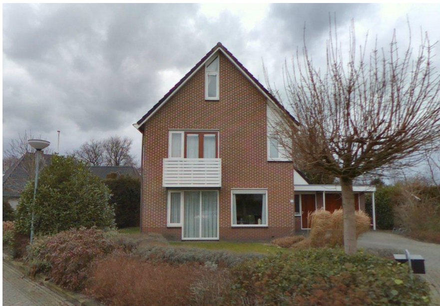
Figuur I - 1 Foto gevel Sierduif 11
