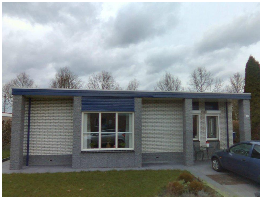
Figuur I-52 Foto gevel Tortelduif 42
