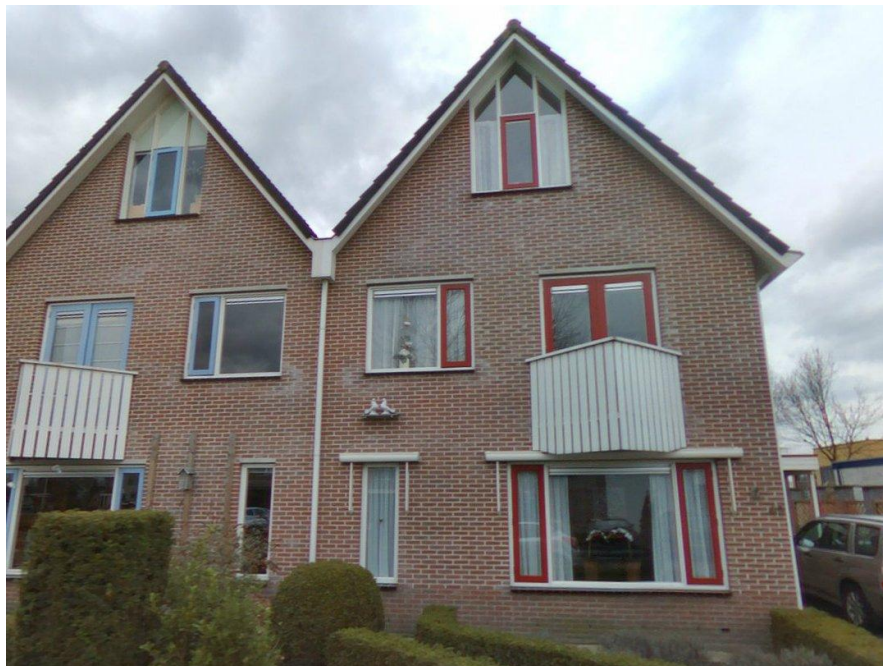
Figuur I-58 Foto gevel Tortelduif 43
