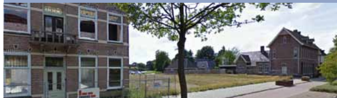
Gaten in gevelbeeld, verval leegstaande bebouwing.
