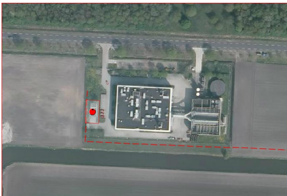
Figuur 13. Gasontvangststation Zwet
