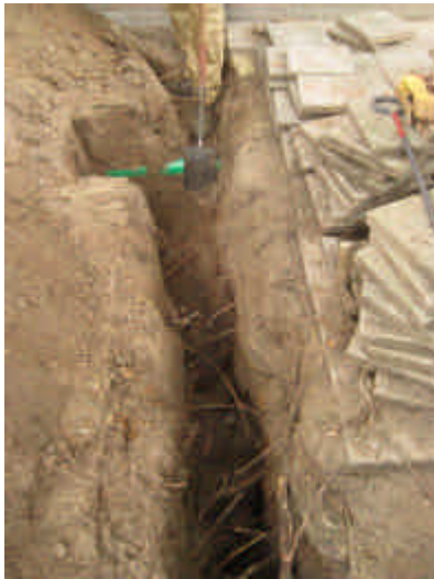
Foto 9/10/11: Op ruim 1m afstand uit de gevel van de woning werd een rioolbuis ingegraven. Tot op ongeveer 2m afstand van de gevel zijn in deze profielsleuf voornamelijk fijnere wortels gevonden. Vanaf 2m afstand uit de gevel neemt de bewortelingintensiteit sterk toe, evenals de omvang van de wortels. De foto hieronder is bij benadering gesitueerd op de plek waar de hoek van het nieuwe gebouw zou moeten komen. De wortels groeien in de richting van de nieuwbouw.
