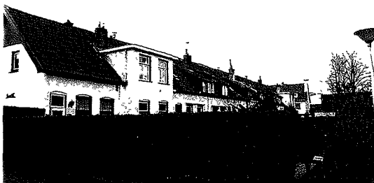
Bestaande bebouwing Gramsbergerstraat
