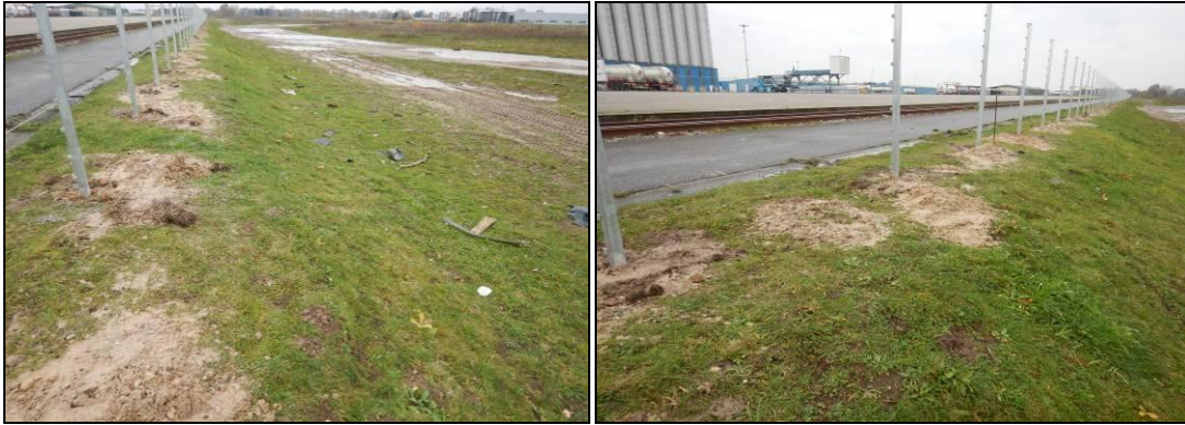
Fig. 7. Locatie gasleiding tussen punt 3 en 4.
