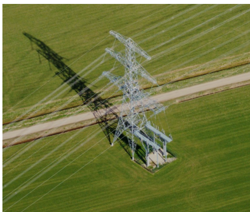
Figuur 2-4: Mast 097 (bron: Cyclomedia)
