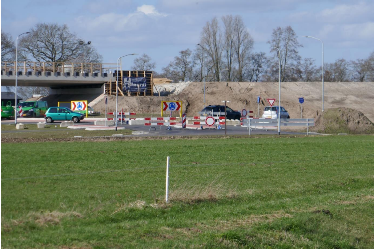
Plek waar de aansluiting met de N34 plaats zal vinden.
