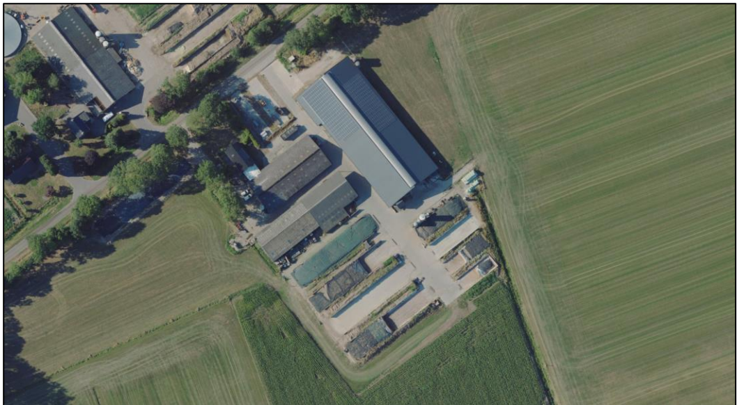
Afbeelding 6: Projectlocatie. Bron: streetsmart.cyclomedia.com
