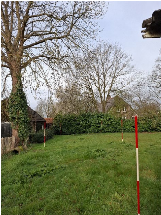
Afbeelding 8: De contouren van de woning en de schuur uitgezet met jalonstokken.
