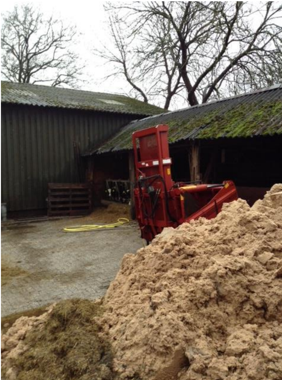
Foto 3: asbestverdacht dak van werktuigenschuur zonder dakgoot
