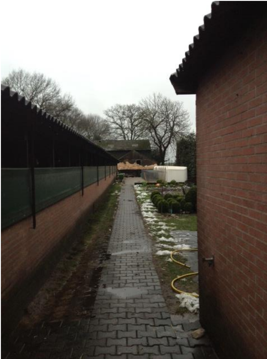
Foto 2: asbestverdachte daken van stal en schuur zonder dakgoot
