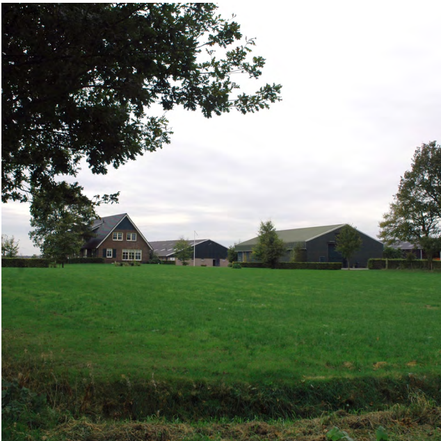
Voorerf met hofjes en daarachter bedrijfsgebouwen
