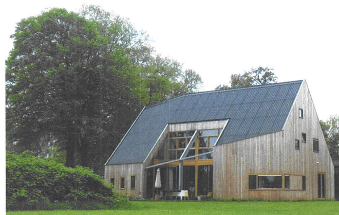
Type schuurwoning, verlopende gootlijn.
