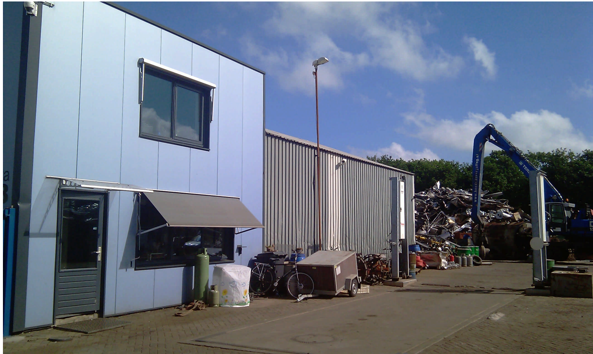
Afbeelding 2.4: Overzicht bedrijfsterrein met kantoor
