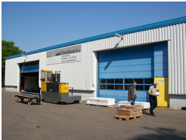
Afbeelding 2.2: zuidgevel met overheaddeuren
