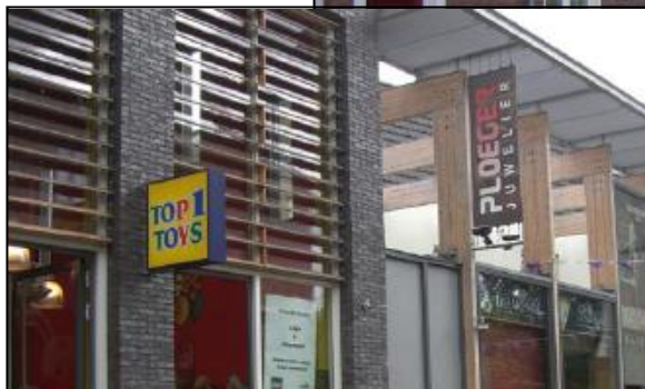
dubbelhoge gevel van de winkels aan het parkeerplein
