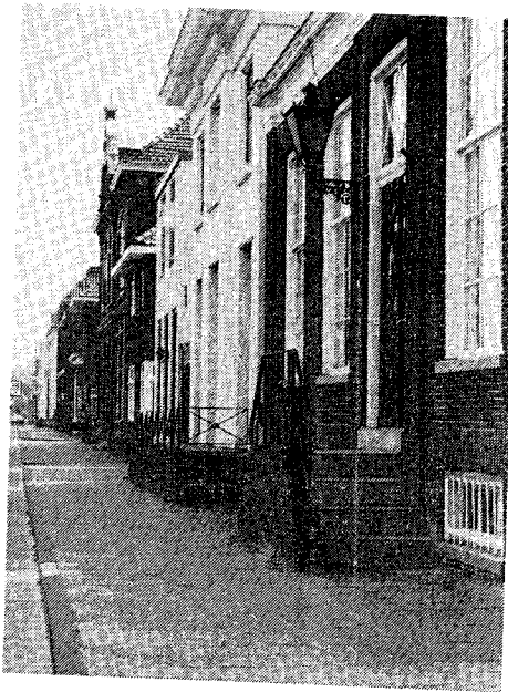
SPECIFIEK KENMERK: VERHOOGDE WONING- TOEGANGEN
