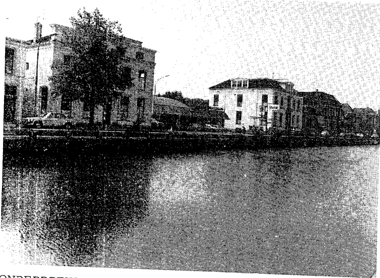
ONDERBREKING VAN DE GEVELWAND
