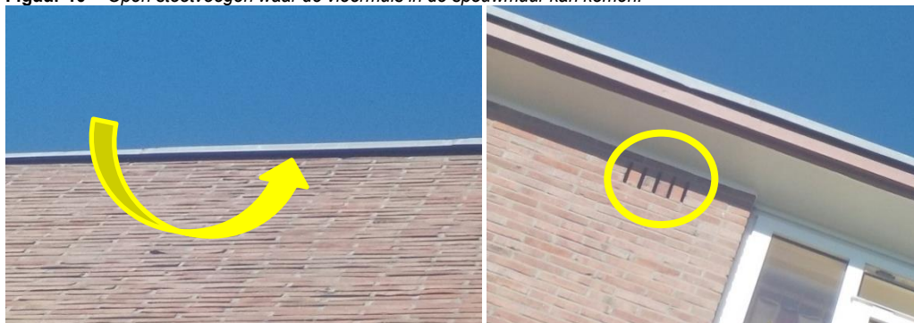
Figuur 11 (links) Ruimte tussen de aluminium daklijst geschikt voor verblijfplaats vleermuis (rechts) Ventilatiespleten met vrije aanvliegroute waar vleermuisen in de spouwmuur kunnen komen.
