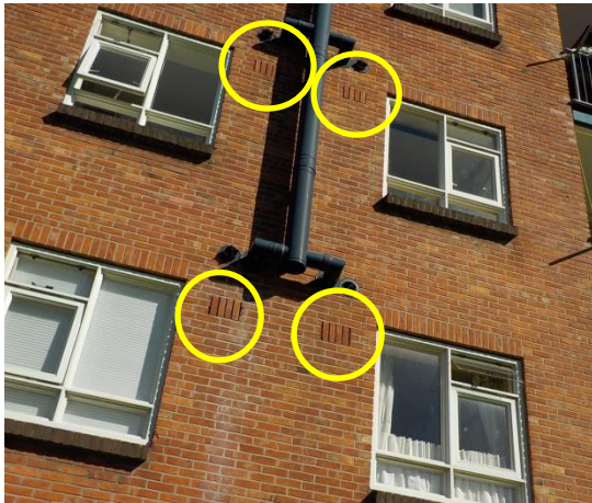
Figuur 7 Ventilatie roosters in de spouwmuur met een vrije aanvliegroute die vleermuizen toegang kunnen bieden tot in de spouwmuur.
