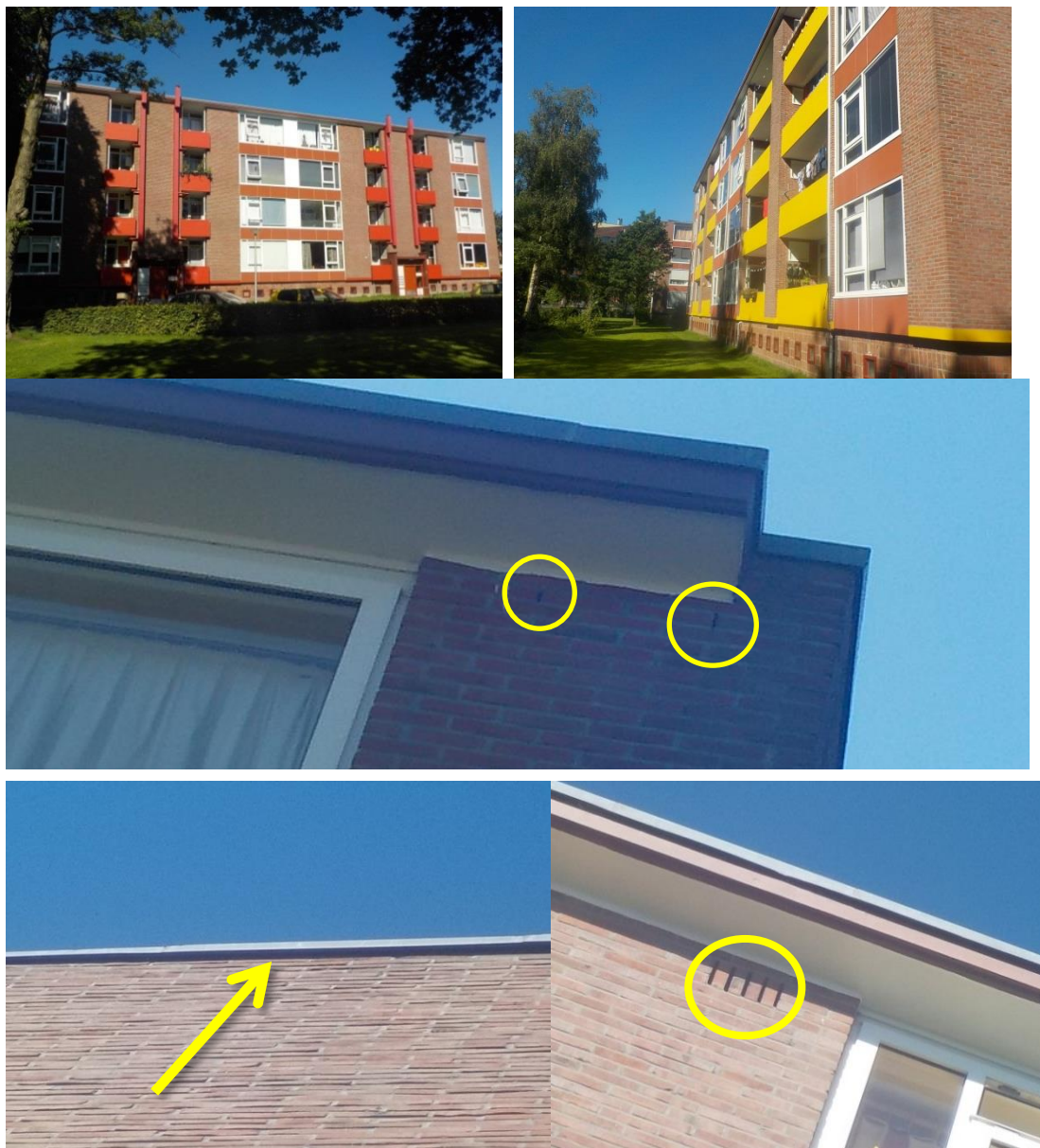
Foto 1 Impressie van de flatgebouwen en de mogelijke invliegopeningen in de flats aan de Thorbeckelaan: open stootvoegen, kieren bij daklijsten en ventilatieroosters.
