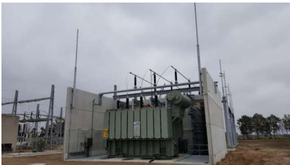
Figuur 4.2 illustratie transformator/transformatorcel met bliksemafleiders
