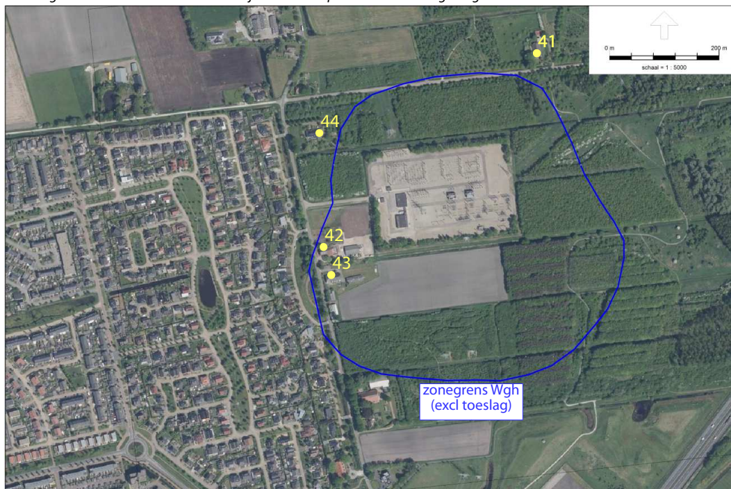
f2.1 Situering transformatorstation Assen Zeijerveen ten opzichte van de omgeving
