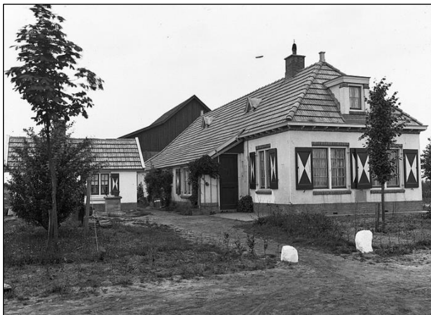
Afbeelding 2.4: Oorspronkelijke bebouwing "De Keet" (Bron: gemeente Assen)
