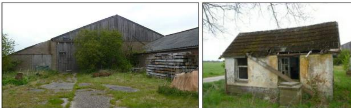
Afbeelding 2.3 Beelden te slopen bebouwing (Bron: Schelhaas makelaardij)
