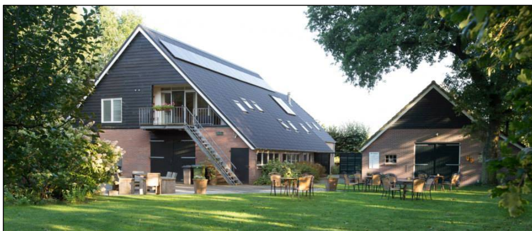
Achterzijde boerderijpand Anreep 16 met rechts het bijgebouw met groepsaccommodatie
