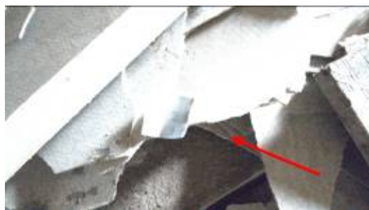
Foto 5 | Restanten vlakke plaat
