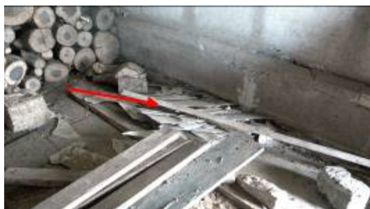
Foto 4 | Restanten vlakke plaat
