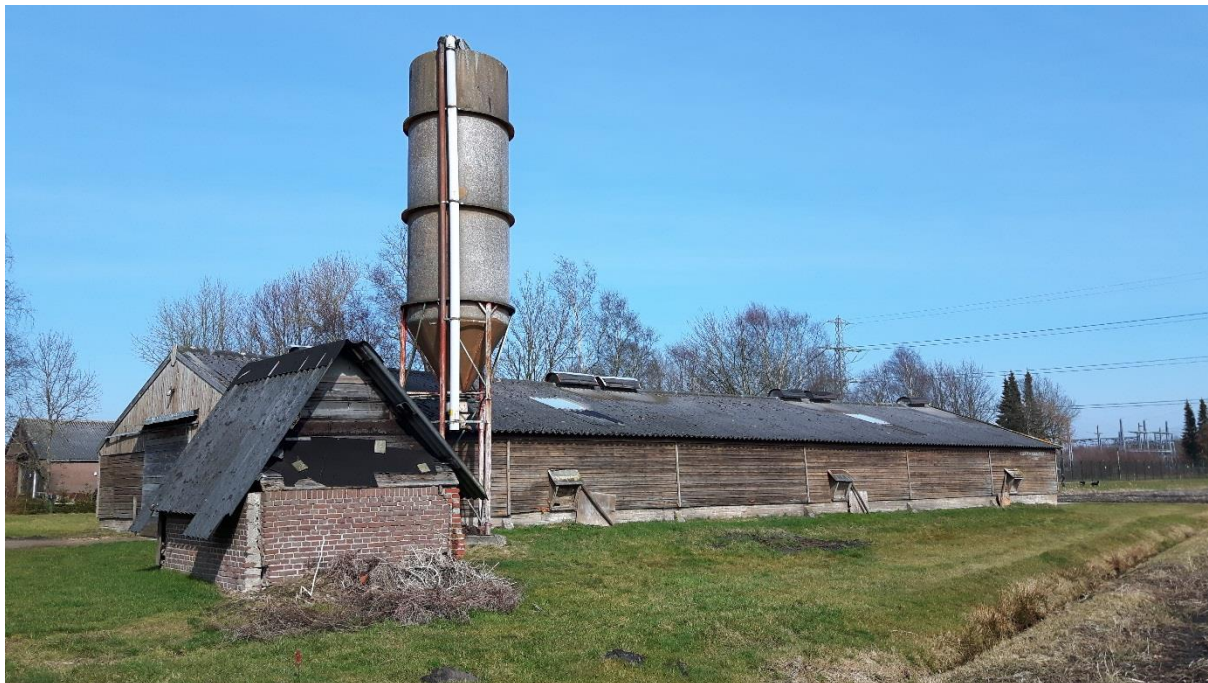
Te slopen opstallen (kippenhuur, silo en kachelhouthok) binnen het plangebied (15 maart 2018).
