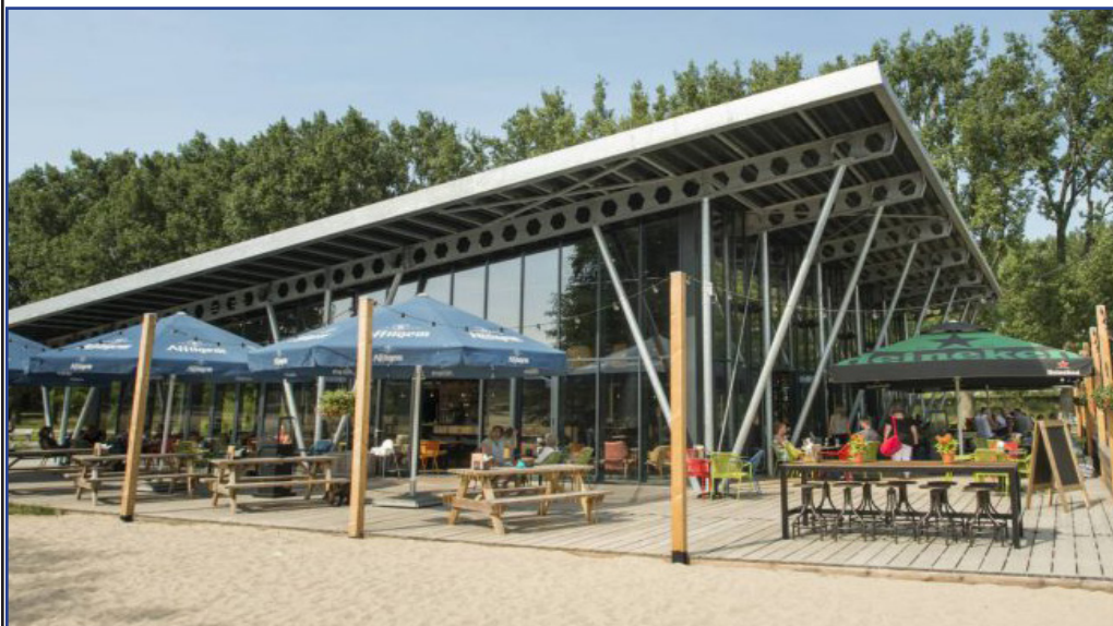
schuin dak dat zich opent naar strand en andere zijde.
