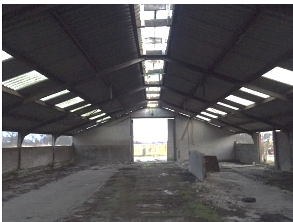
Figuur 2 Alle agrarische opstallen worden gesloopt ten behoeve van een nieuwe woning ten zuiden van de Graswijk 35. Foto: te slopen voormalige rundveestal.
