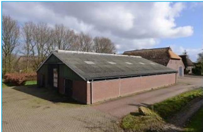
Foto de slopen bedrijfsgebouw aan de Deurze 14 – oppervlakte is circa 390 m 2
