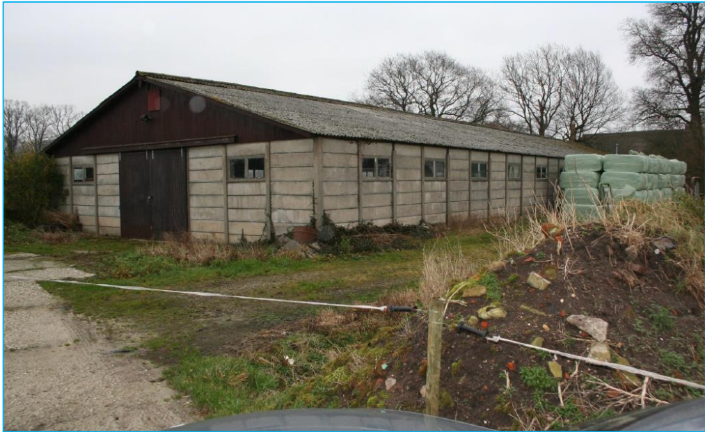
Foto de slopen bedrijfsgebouw aan de Schieven – oppervlakte is 530 m 2
