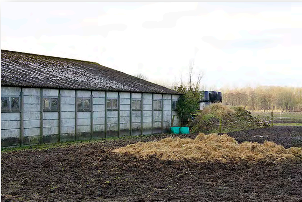
Te slopen schuur, zicht in westelijke richting
