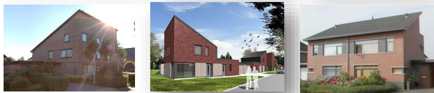
Referenties lessenaarsdaken, dakvlak op zuiden gericht
