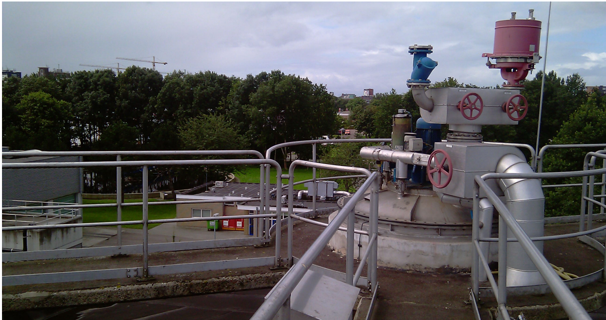
Afbeelding 2.7: overzicht mixers gistingstank
