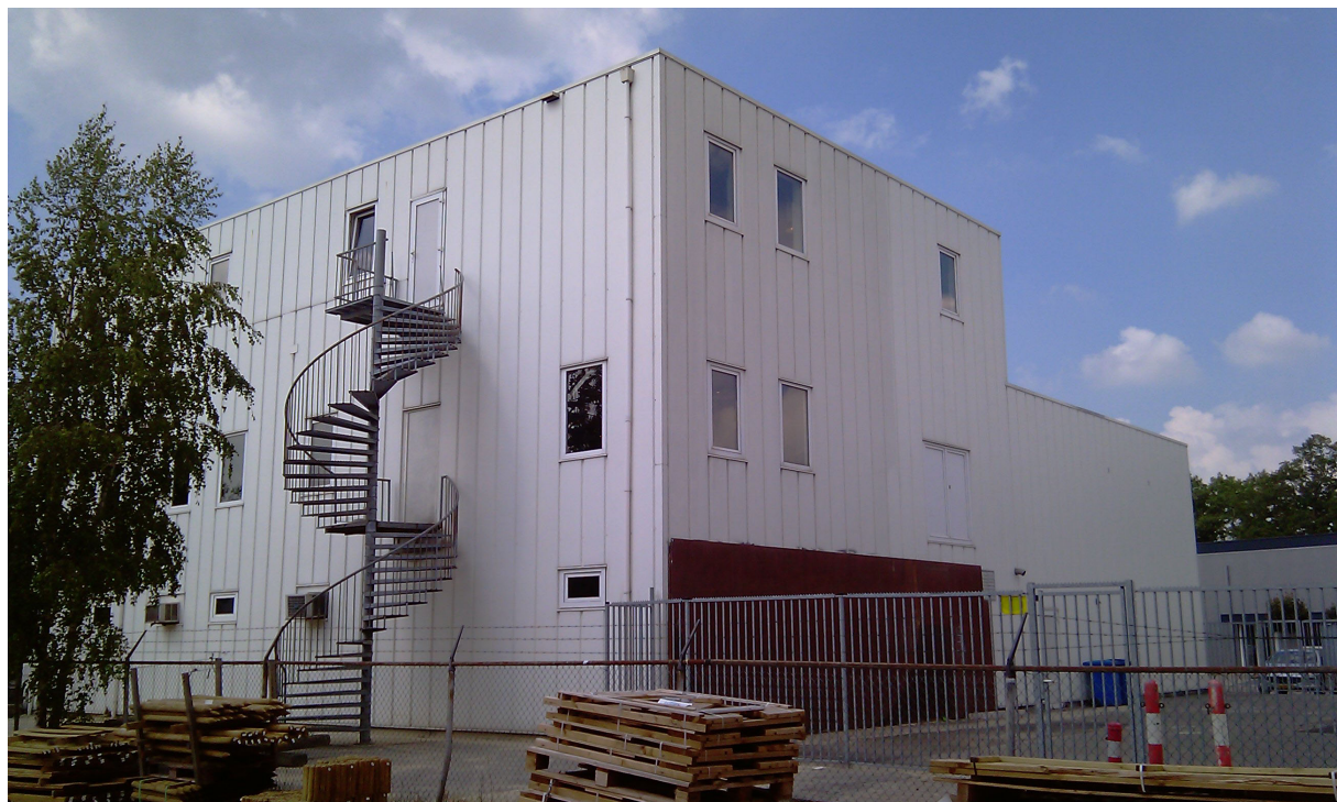
Afbeelding 4.3: overzicht zuidgevel aerobicsruimte en spinningruimte (2 e verdieping)
