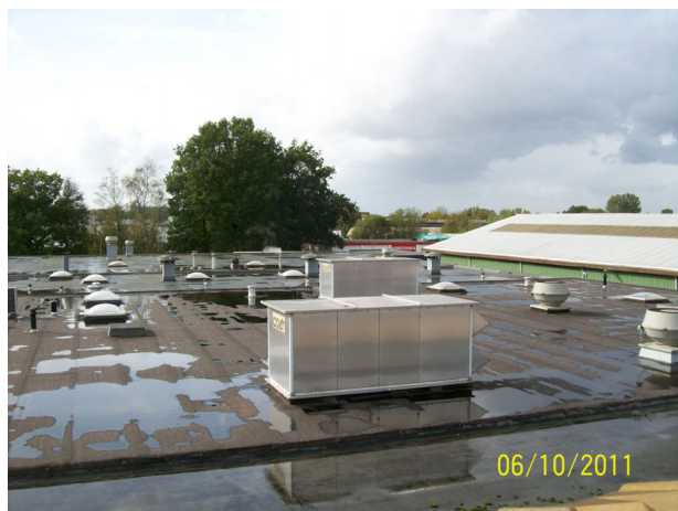
Afbeelding 4.1: geluidbronnen dak westzijde
