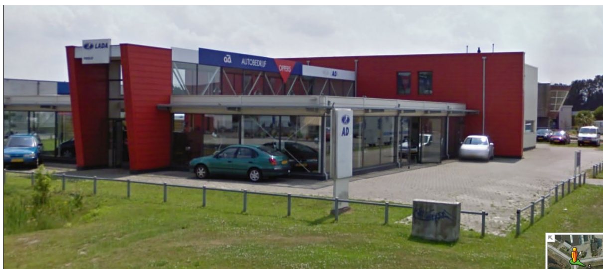
Afbeelding 2.2: overzicht voorzijde werkplaats
