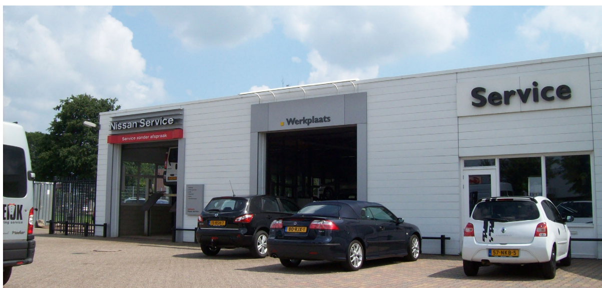
Afbeelding 2.2: overzicht voorzijde werkplaats
