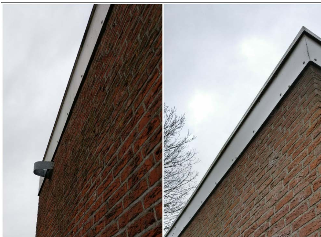
Figuur 4.1 Ruimte tussen boeiboorden en het metselwerk kan worden benut als verblijfplaats voor vleermuizen
