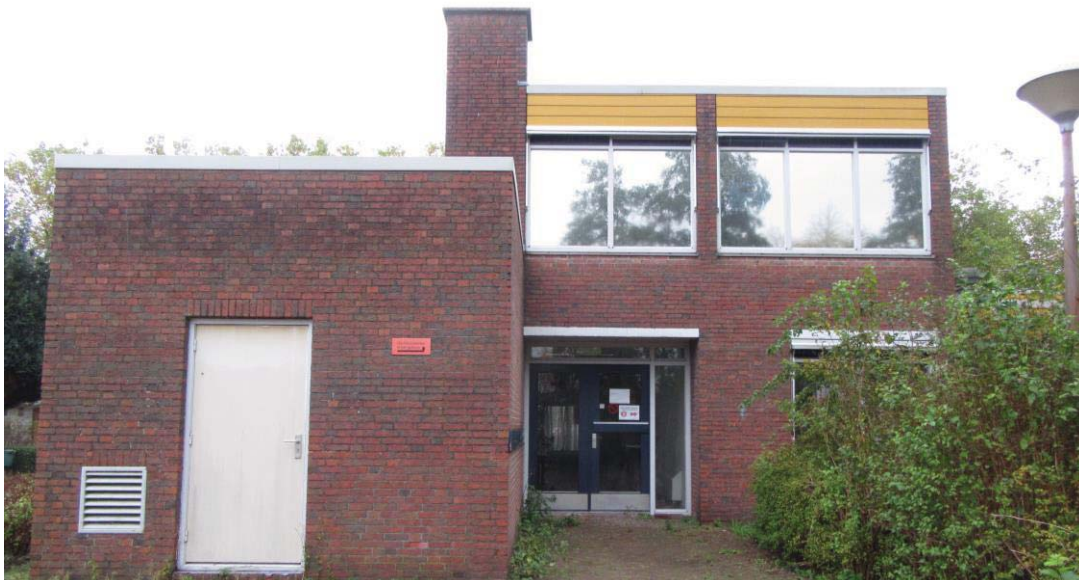
Figuur 2.9. Noorzijde kantoorpand (linker gedeelte).
