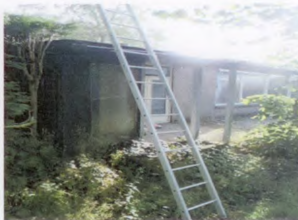
Toelichting bij foto 12: Het dak van de woning is beklommen met behulp van een ladder.
