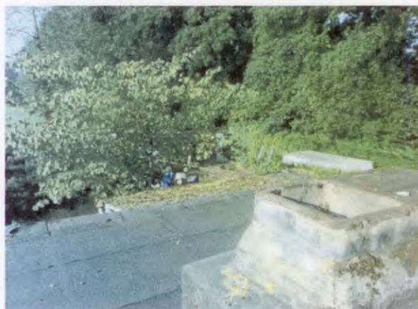
Toelichting bij foto 11: Overzicht dak. Het dak is bedekt met dakleer.
