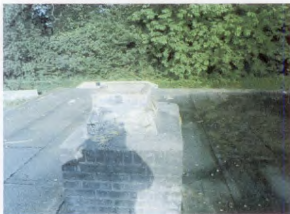
Toelichting bij foto 9: De schoorsteen. Van de schoorsteen op het dak is het hoedje verwijderd, deze zat geschroefd.
