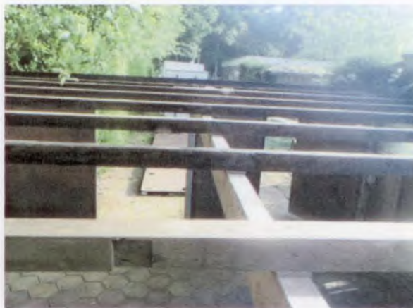
Toelichting bij foto 6: Van het dak zijn golfplaten verwijderd. De golfplaten zaten geschroefd op draagbalken.
