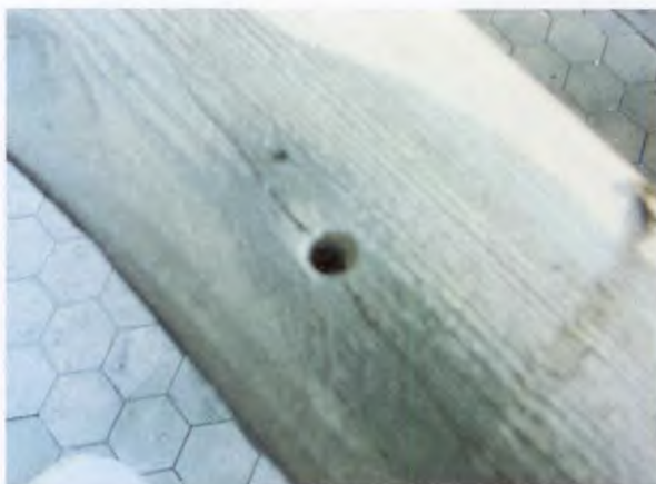
Toelichting bij foto 7: In de ruwe balk is in naden, kieren, schroefgaten en porien beperkte inspectie mogelijk.
