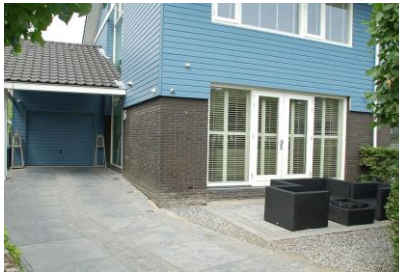
Metselwerk in combinatie met hout
