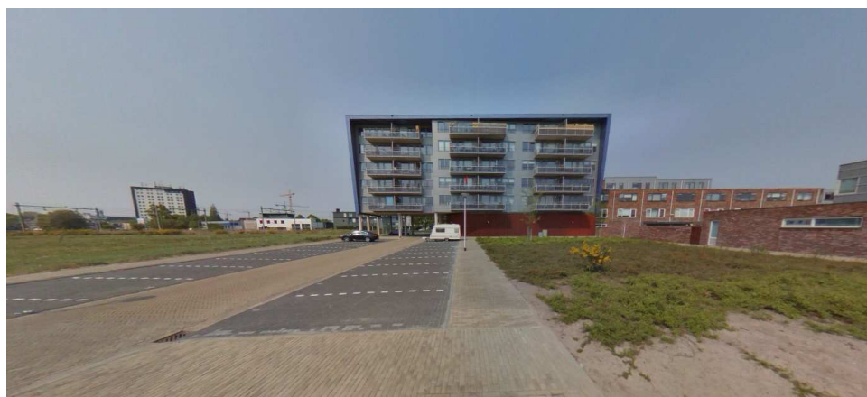
Figuur 15. Foto pleintje en doorzicht naar het spoor
